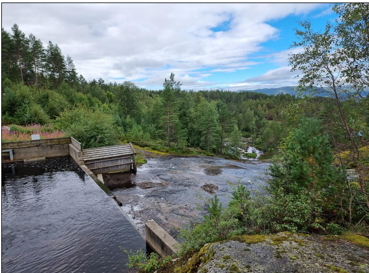
Figur 2.3. Bergesli kraftverk er etablert i utløpselven til Åsevatnet. Foto: Knut Børge Strøm.
